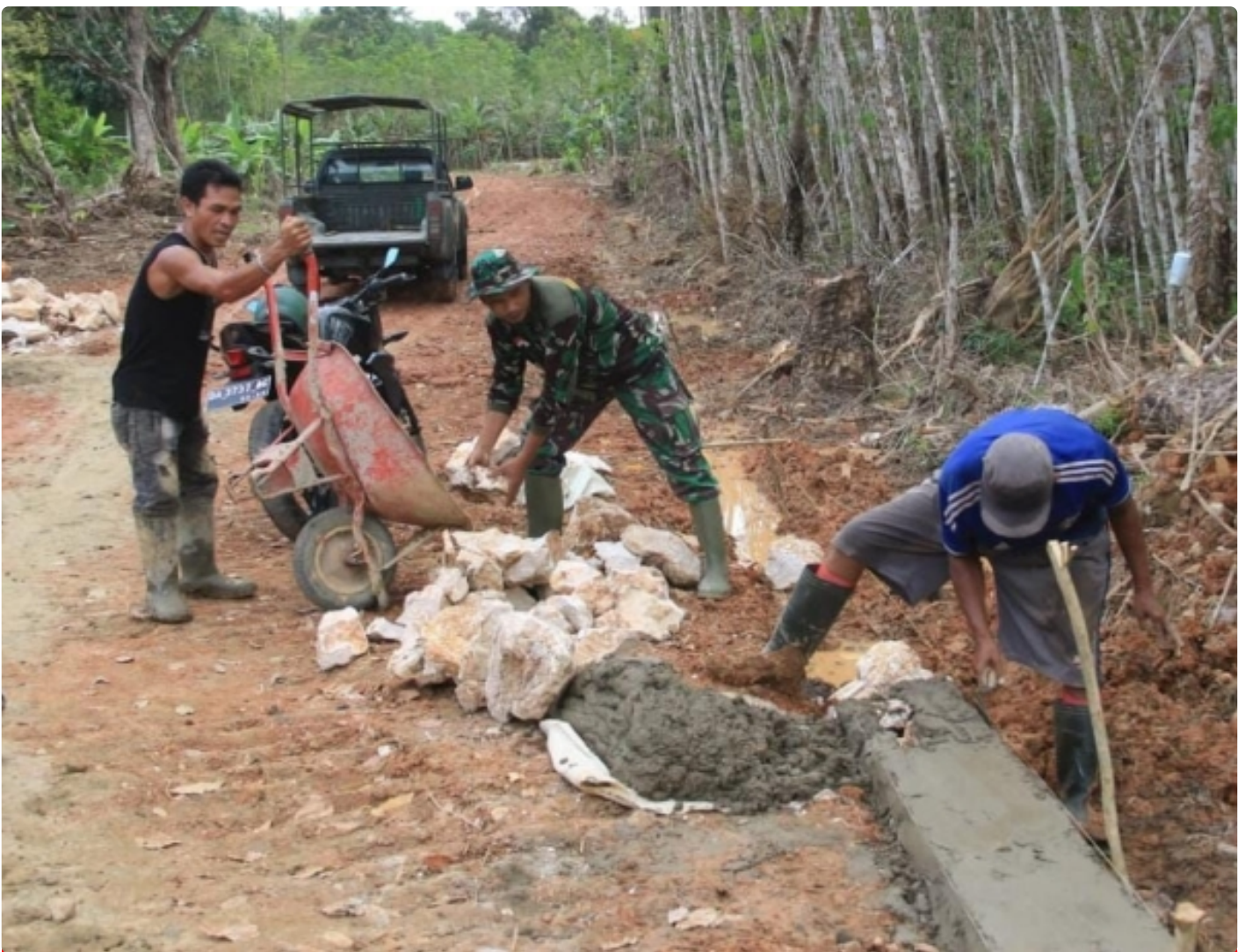
Pembuatan Badan Jalan Sepanjang 1020 meter Capai 45 Persen
