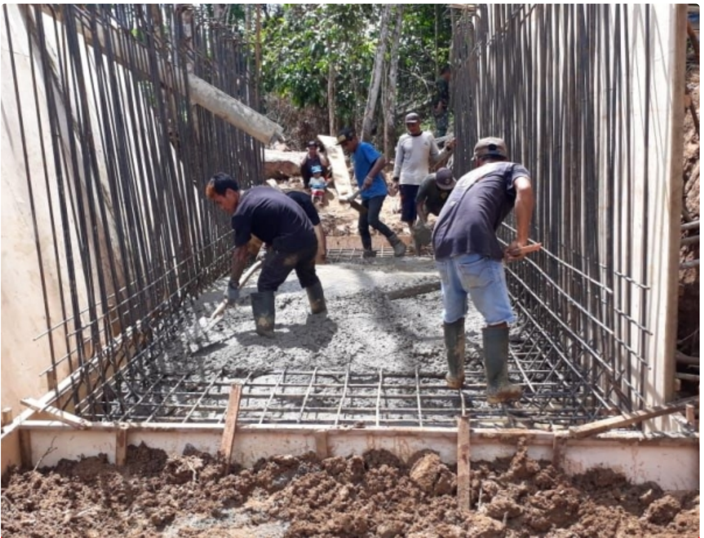
Progres Pembuatan Jembatan Box Culvert Program TMMD Kodim Tabalong Capai 60%
